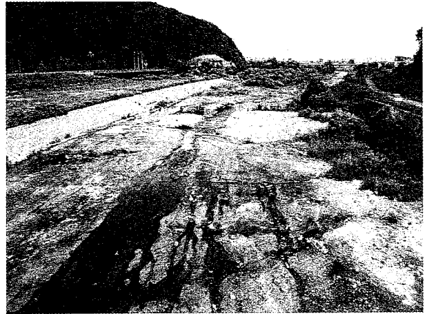
図4 五輪大橋から見た豊平川。河床の石がなくなり、泥岩質の岩盤が露出している。
