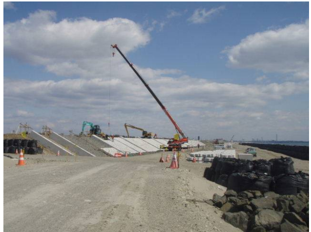
写真-6. 海浜での工事 (仙台荒浜)
