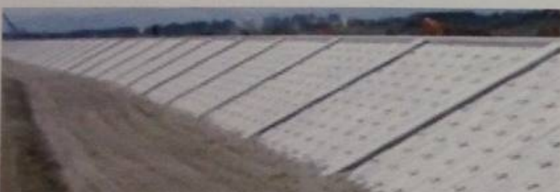
仙台湾南部の防潮堤 (国土交通省東北地方整備局HPより)
